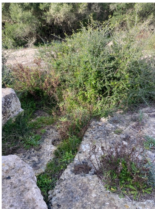
Figura 1478. Estat actual de les canalitzacions a la superfície de la terrassa de captació d'aigua.
