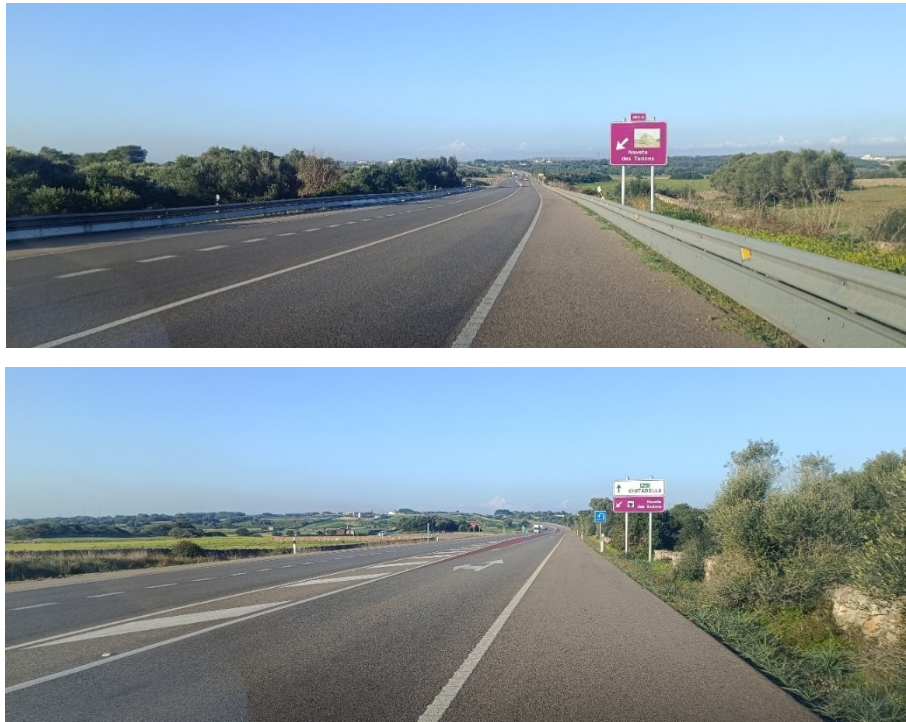
Figura 40. Senyals indicatius de carretera en direcció Ferreries a Ciutadella, a 250 i 160 m. de l'entrada a l'aparcament de la naveta des Tudons.
