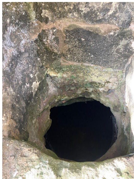
Figura 149. Vista de l'interior dels dos colls de cisterna, sense cap sistema de seguretat per evitar possibles accidents.
