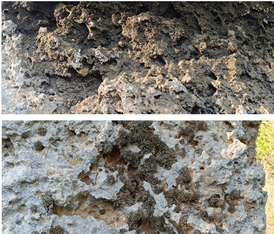
Figura 102. Picats, alvèols, cavernes i recobriments biològics a la pilastra suport de la taula.
