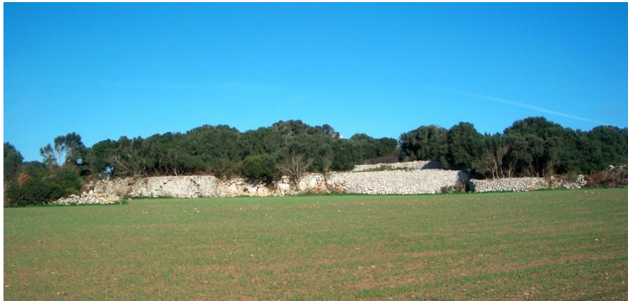
Figura 47. La muralla des del sud-oest del poblat.
