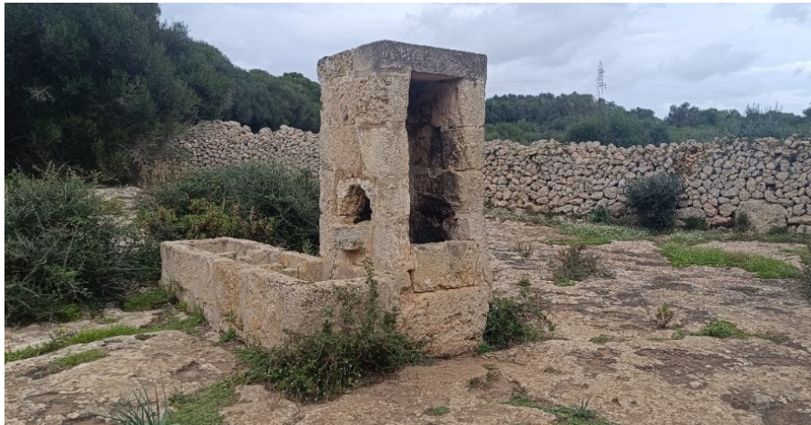
Figura 127. Terrassa de captació d'aigua i coll de cisterna central.
