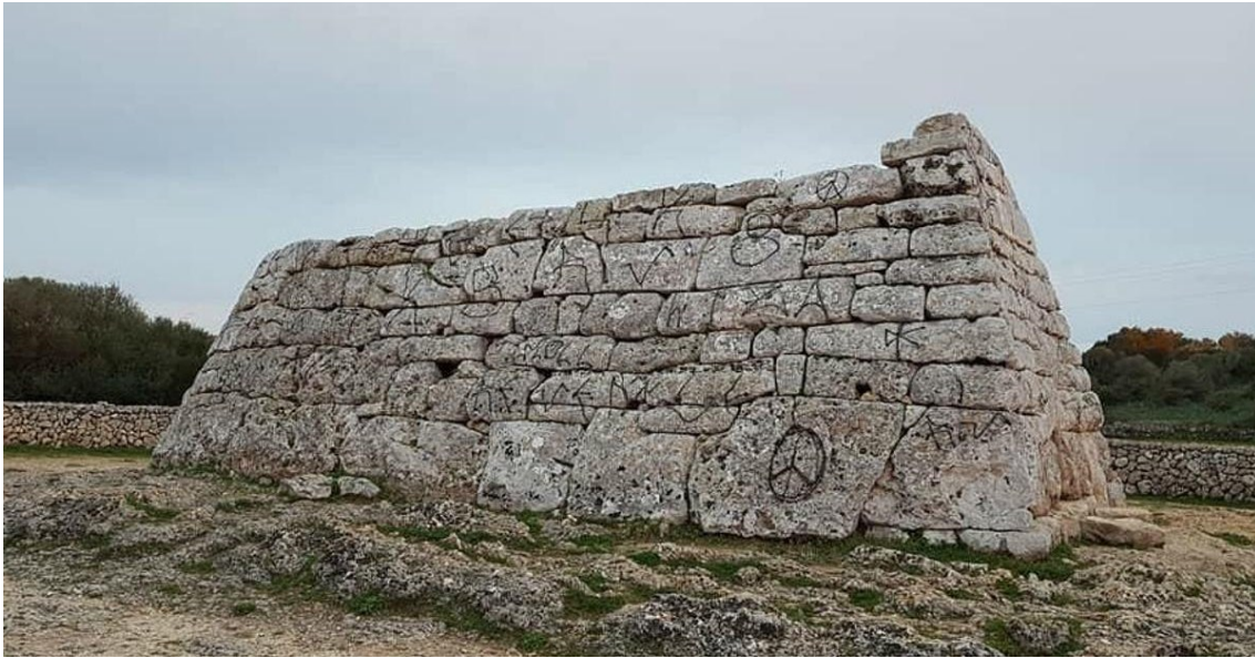
Figura 15. Costat nord de la naveta amb les pintades aparegudes el març de 2018. Els grafitis van afectar un total de 81 blocs de pedra del monument. Foto: David Arquimbau, Ara Balears.
