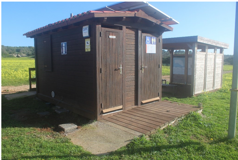
Figura 22. Bany adaptat amb rampa d'accés.
