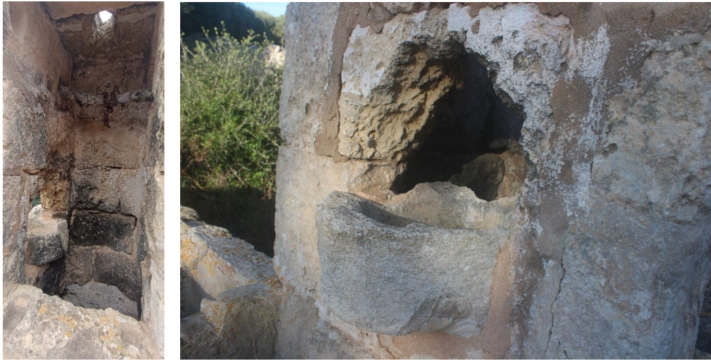
Figura 114. Detalls de la degradació del coll de la cisterna central de la terrassa de captació d'aigua.
