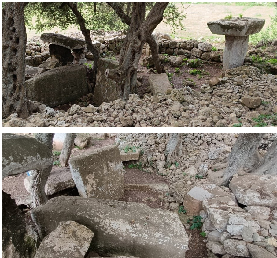
Figura 62. Recinte de taula. Es veuen els ullastres més prims que envaeixen la zona excavada, al centre del recinte, on hi ha els blocs caiguts que formaven el monument central.
