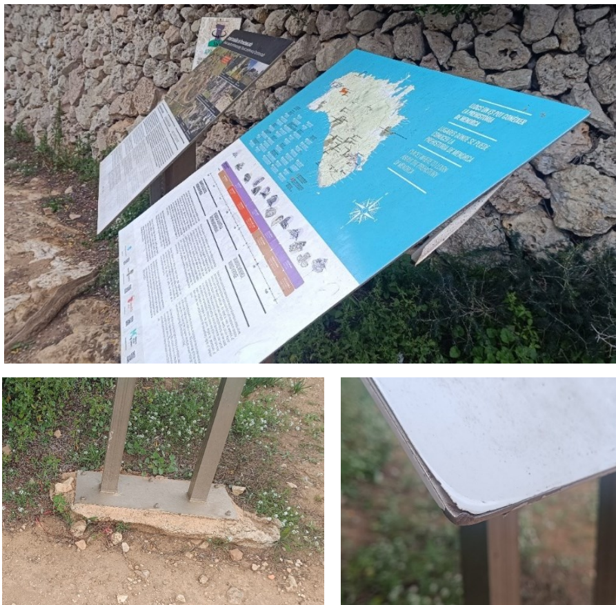
Figura 118. Detalls de l'estat defectuós dels plafons interpretatius de l'inici del recorregut.
