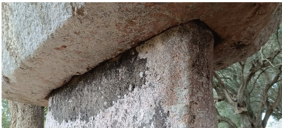
Figura 63. Pilastra iconostàtica. S'aprecia el rebaix a la llosa capitell per encastar-hi la pilastra de suport.
