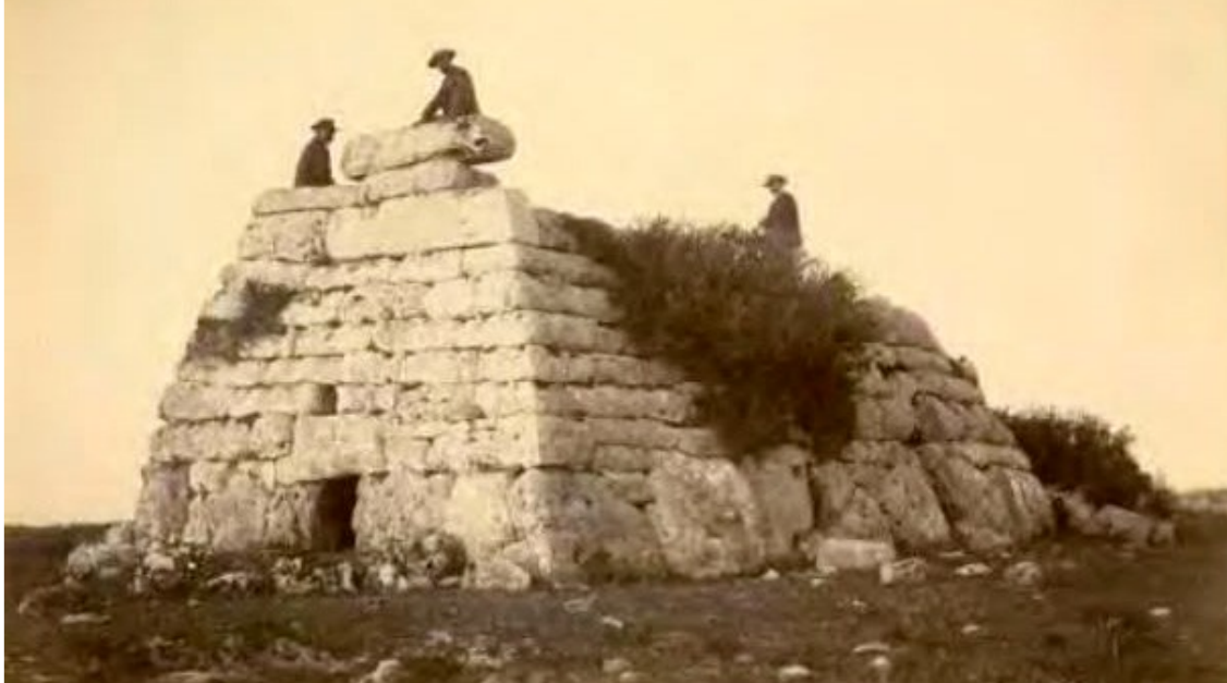
Figura 14. Estat de la naveta des Tudons a principis del segle XX. S'observa la colonització del monument pels ullastres, que provocarien l'esfondrament parcial de l'absis. La restauració duta a terme el 1960 va significar el final de l'amenaça de la vegetació llenyosa per a la integritat de la naveta. Foto: Antonio Vives Escudero, Inventari dels monuments artístics d'Espanya (1905-1909).
