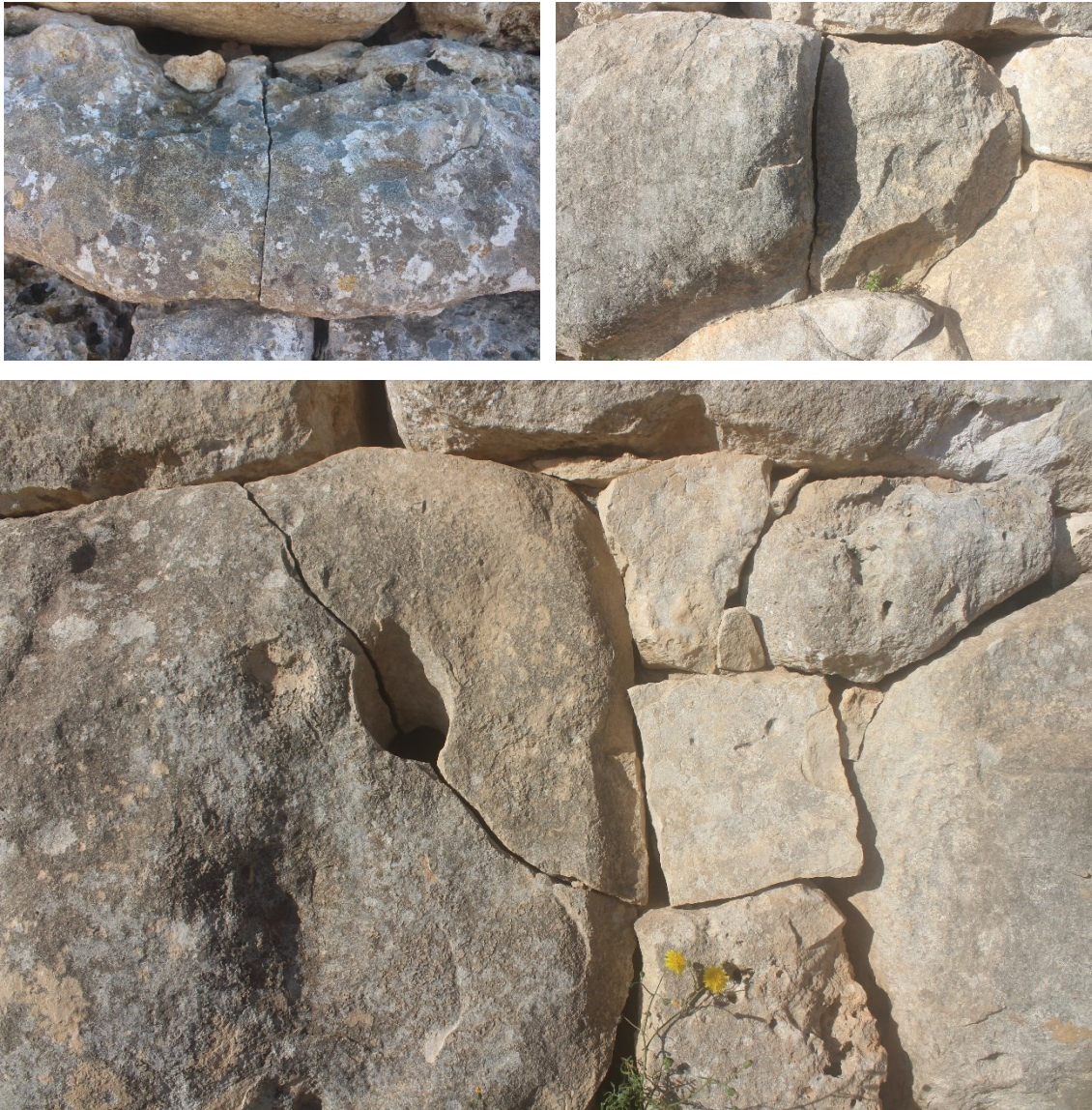
Figura 18. Diàclasis a blocs de la naveta.
